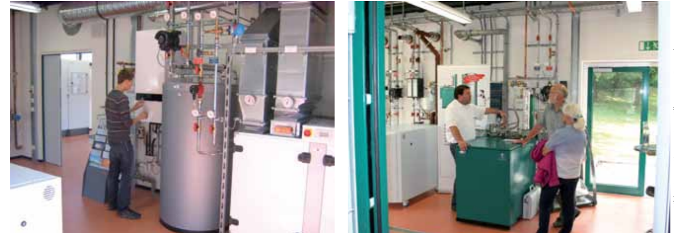
Eine Luft-Wasser- und eine Sole-Wasser-Wärmepumpe samt Schichten-Pufferspeicher gehören ebenso zur Ausstattung des Innovationszentrums wie drei Blockheizkraftwerke. Hier können sich nach Anmeldung auch Verbraucher über einzelne Techniken informieren.
