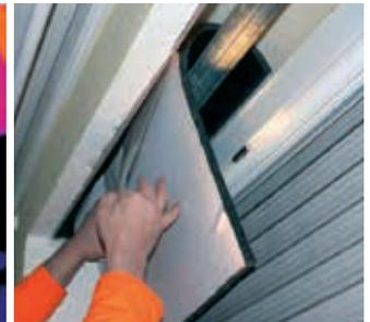
Abb. 19: Einbau einer 20 mm starken Dämmplatte
