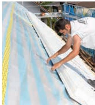
Abb. 7: Aufsparrendämmung
