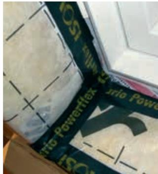
Abb. 10: luftdichter Anschluss am Fenster
