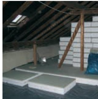
Abb. 11: Deckendämmung im Bau
