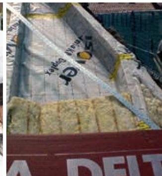
Abb. 8: Zwischensparrendämmung
