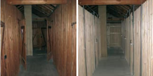
Abb. 13: alter und sanierter Dachboden (re.) mit begehbarem Belag und neuen Verschlägen
