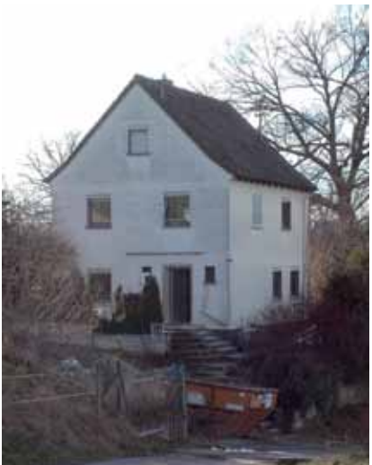
Michael Reeb , Altbausanierung Einfamilienhaus
