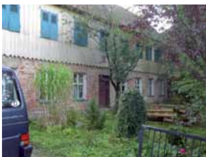
Romer-Architekten , denkmalgeschützter Altbau um 1800
