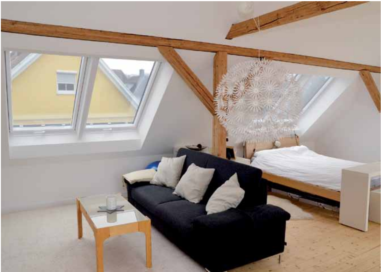
Im Dachgeschoss wurden hochwertige Fenster mit hohem Wärmedämmwert verbaut.
